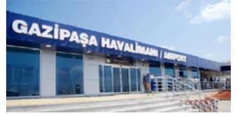
Gazipaşa Havalimanı Alanya, Güneş Enerjili Uçak İkaz Lambası, IV SOLAR
