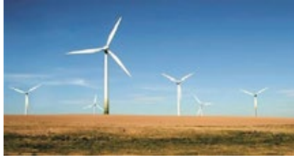
Meriç Elektrik Rüzgar Enerjisi, Orta Yoğunluklu Uçak İkaz Lambası, ORGA
